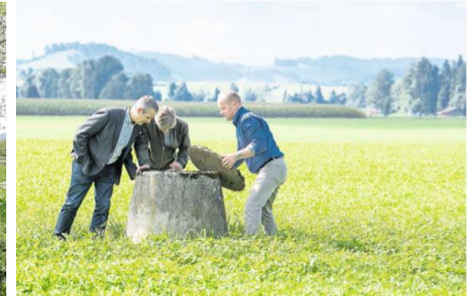
Entwässerungsschacht in der Wauwiler Ebene, der durch den kontinuierlichen Abbau organischer Bodensubstanz aus dem Boden gewachsen ist. (Foto: Luzerner Zeitung, 04.09.2019)
